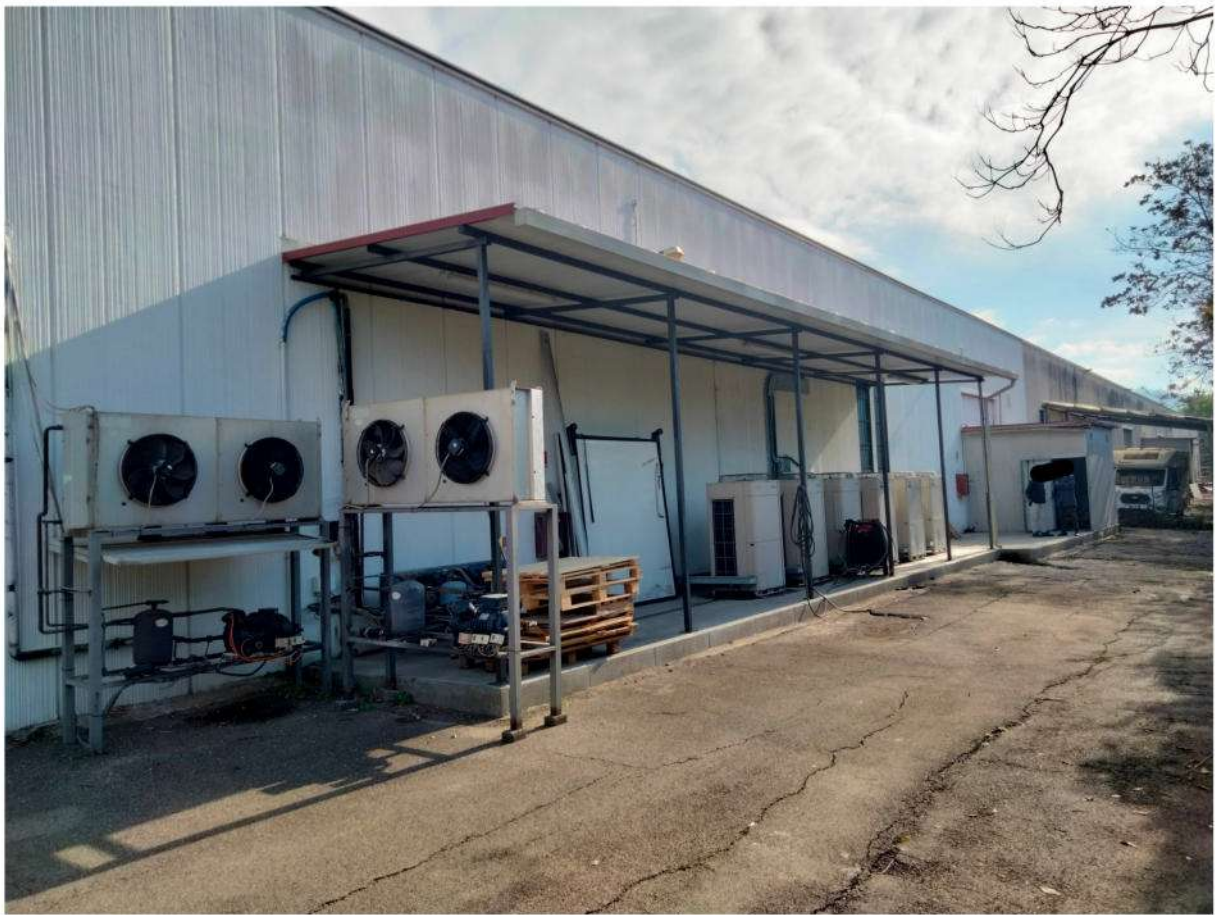
FOTO N. 21 - LATO RETRO CON TETTOIA A PROTEZIONE DEI MOTORI FRIGORIFERI
