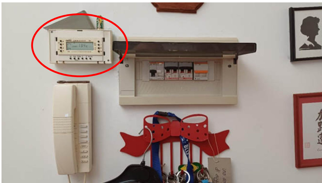
Impianto termico_Cronotermostato_10
