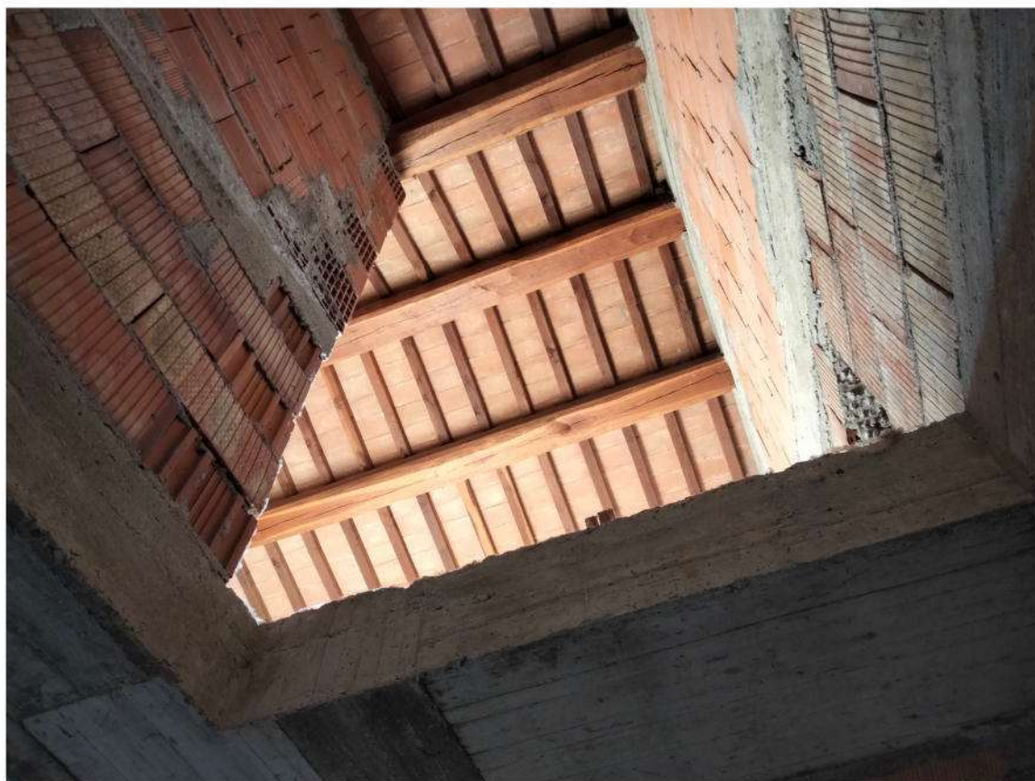
FOTO N. 4 - FORO SUL SOLAIO PER ACCESSO AL PIANO PRIMO
