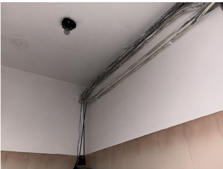
Impianti Tecnologici "a vista" che passano all'interno del vano Bagno
