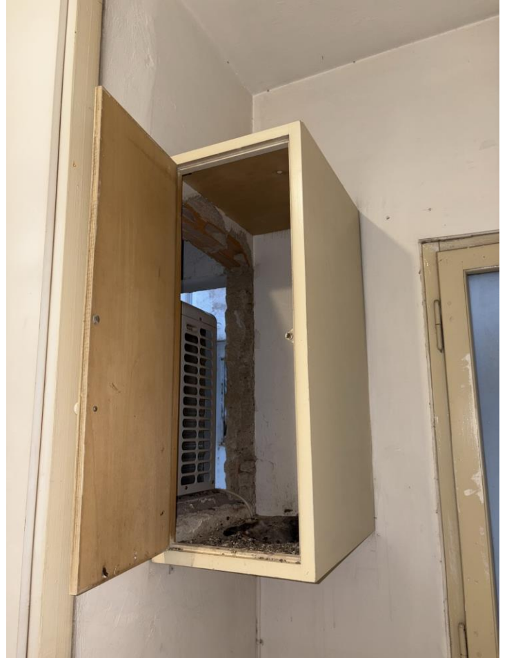
Armadio a muro e Cassonetto ubicati nel vano Ripostiglio che affaccia sulla Chiostrina interna condominiale realizzati appositamente per posizionare e ispezionare i motori dei condizionatori
