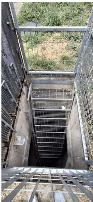
SCALA DI ACCESSO PER MANUTENZIONE
