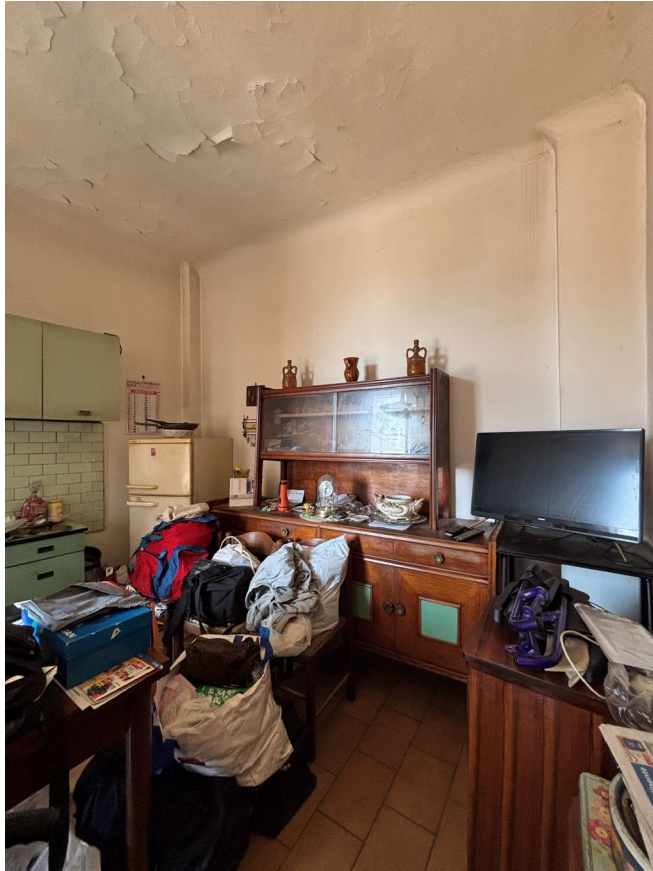
Immagine 8. Il locale di ingresso che corrisponde alla cucina abitabile; si nota che a soffitto si manifestano gli effetti di infiltrazioni dal tetto.
