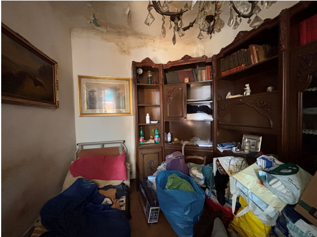
Immagine 12. Il soggiorno. I fenomeni infiltrativi si manifestano con danni importanti al plafone e alle pareti.
