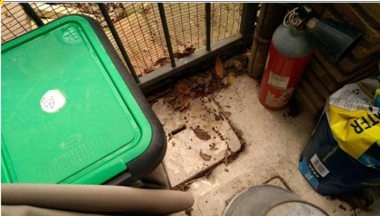
Pozzeto ispezione fossa Imhoff
