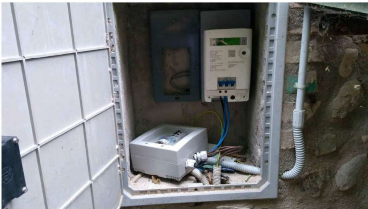
Contatore elettrico
