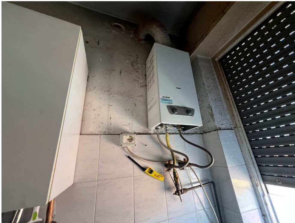
Fotografia n. 21 – Particolare dello scaldabagno presente nel locale angolo cottura
