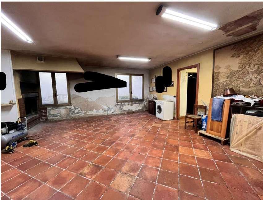
Immagine 31. Grande locale multifunzione al piano interrato; sullo sfondo un camino e due finestre che aprono su una intercapedine; si notano fenomeni di umidità di risalita sui muri perimetrali.
