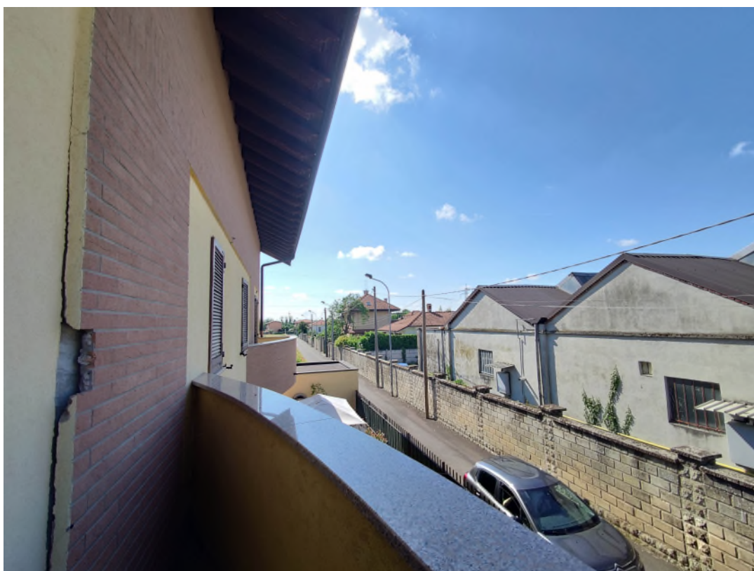
Immagine. 18. Balcone con dettaglio rivestimento mattone paramano distaccato.
