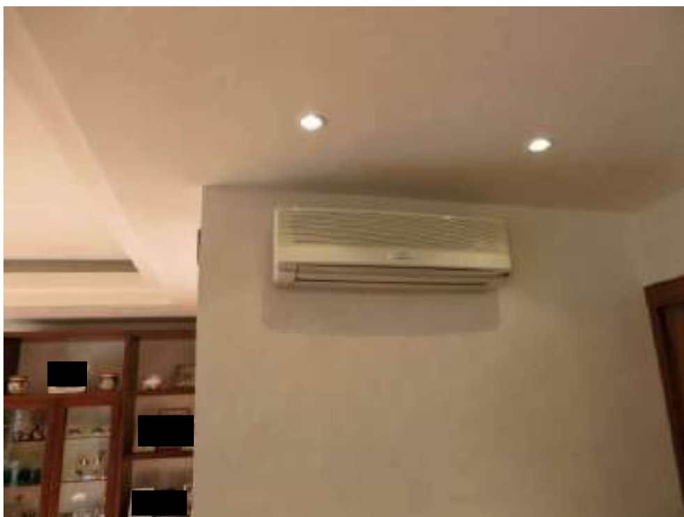
FOTO 58: UNITA' INTERNA DEL CLIMATIZZATORE (Secondo Piano)
