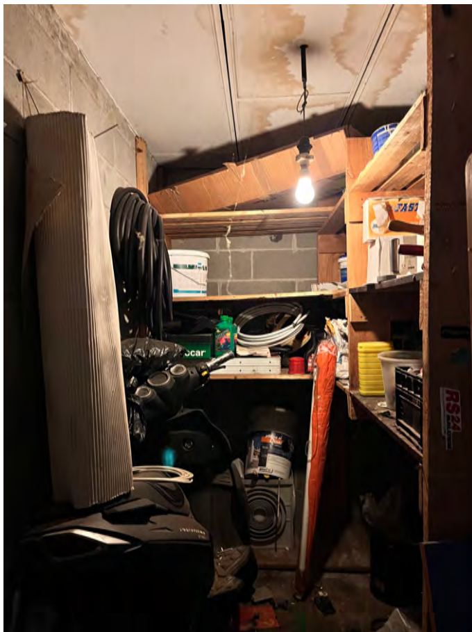
Immagine 22. La cantina sul controsoffitto si notano segni di una pregressa infiltrazione dai piani superiori.
