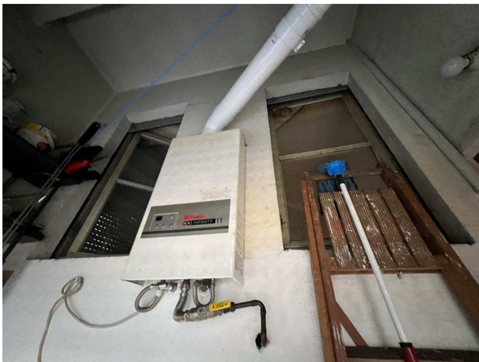
Fotografie n. 28/29 – Particolari dello scaldabagno a gas (marca Rinnai modello Infinity 11) presente nella loggia
