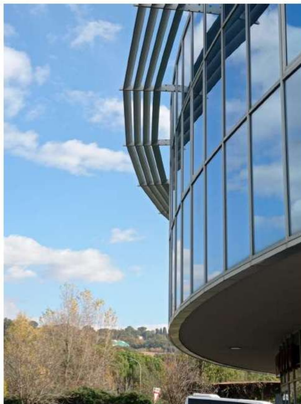
Foto n. 11: dettaglio facciata esterna/vetrata e frangisole.
