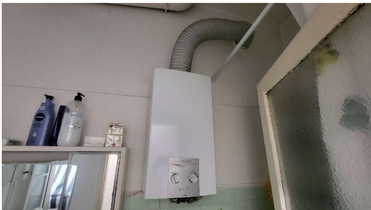
Dettagli – Caldaia autonoma per produzione acqua calda sanitaria
