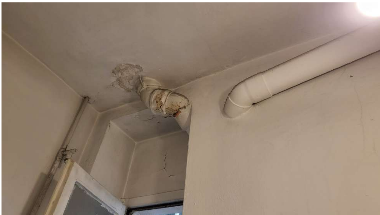
Dettagli – Infiltrazione d'acqua sul plafone del bagno
