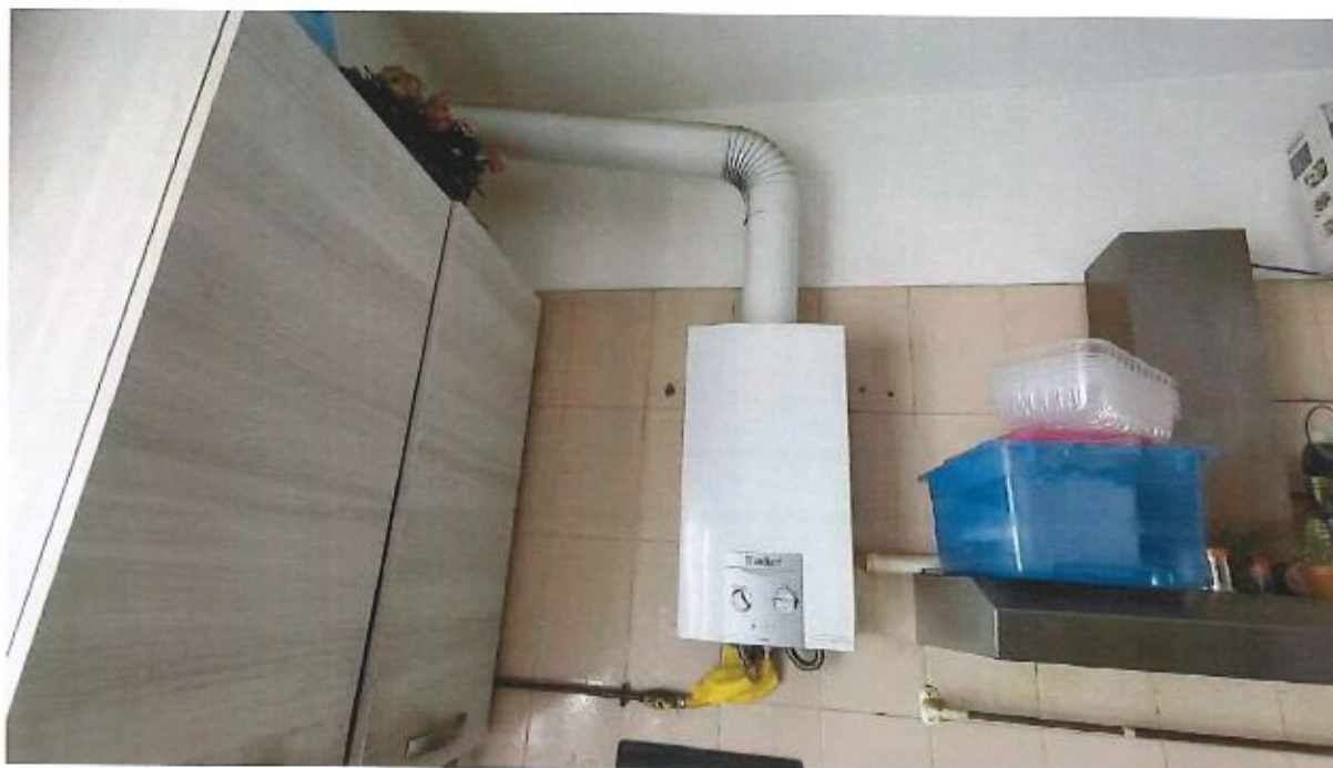
Dettagli – Caldaia murale a gas metano per produzione acqua calda sanitaria
