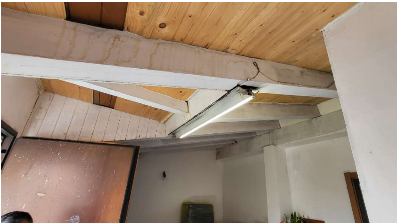
Dettagli – Muffa e infiltrazioni sull'orditura secondaria della copertura
