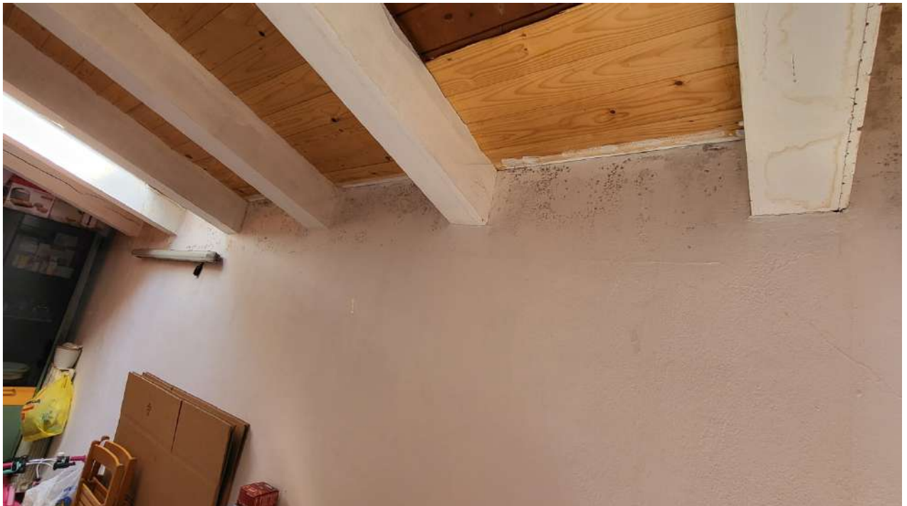
Dettagli – Muffa sulle pareti e infiltrazioni sull'orditura secondaria della copertura
