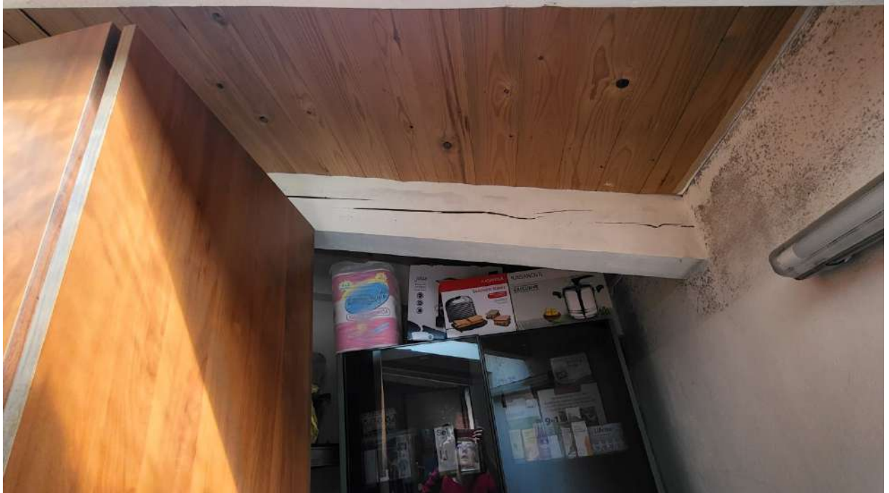
Dettagli – Crepe nell'orditura secondaria della copertura e muffa sulle pareti
