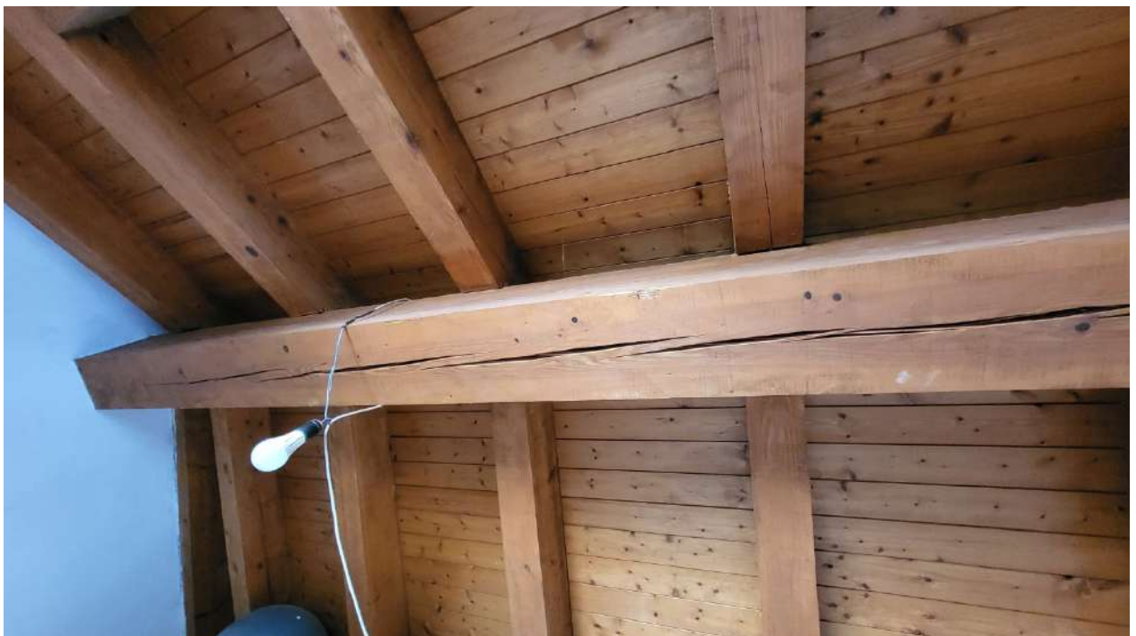
Dettagli – Crepe nella trave di colmo della copertura
