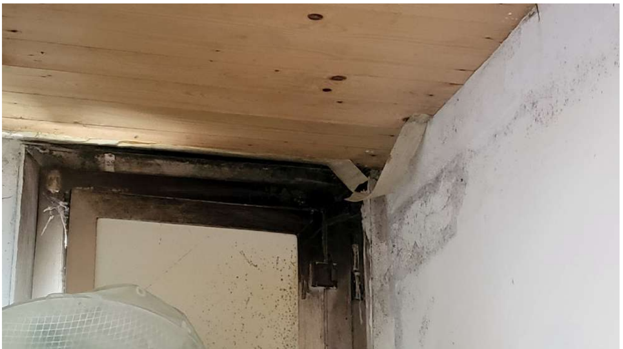
Dettagli – Muffa sulle pareti
