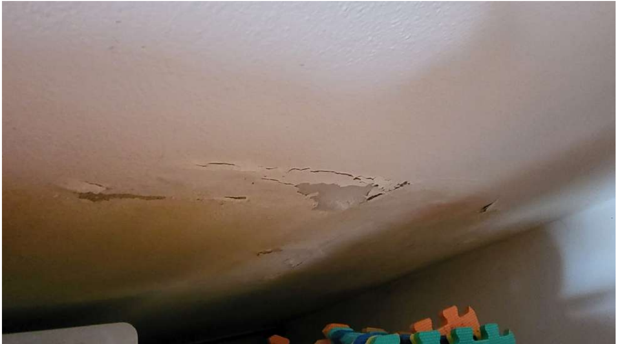
Dettagli – Infiltrazioni, efflorescenze saline e rigonfiamenti e distacchi della pittura
