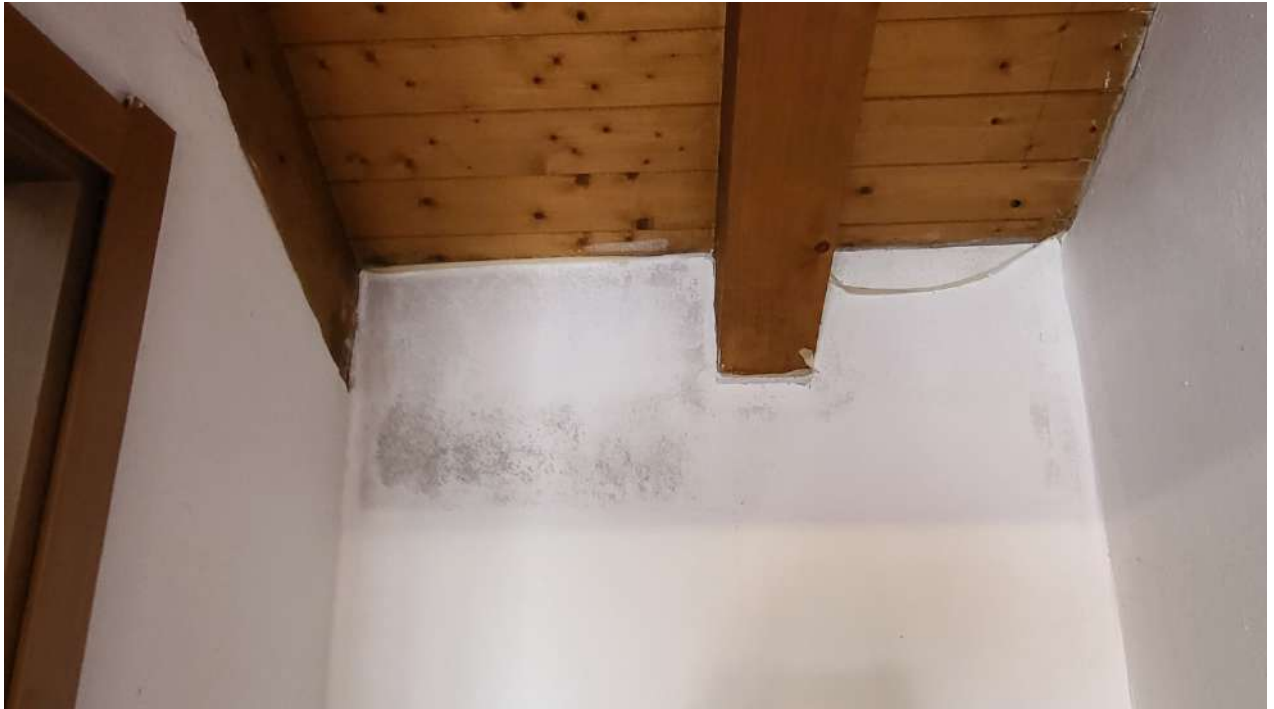
Dettagli – Muffa sulle pareti
