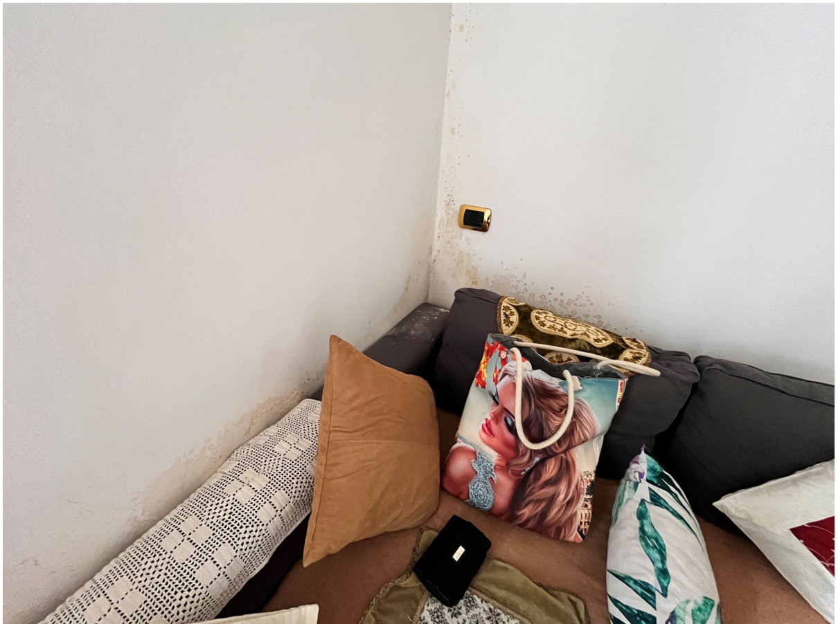
Foto 19. L'unità immobiliare è interessata da muffe, in particolare sui muri freddi.
