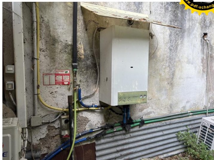
Caldaia per la produzione di acqua calda sanitaria (dismess)
