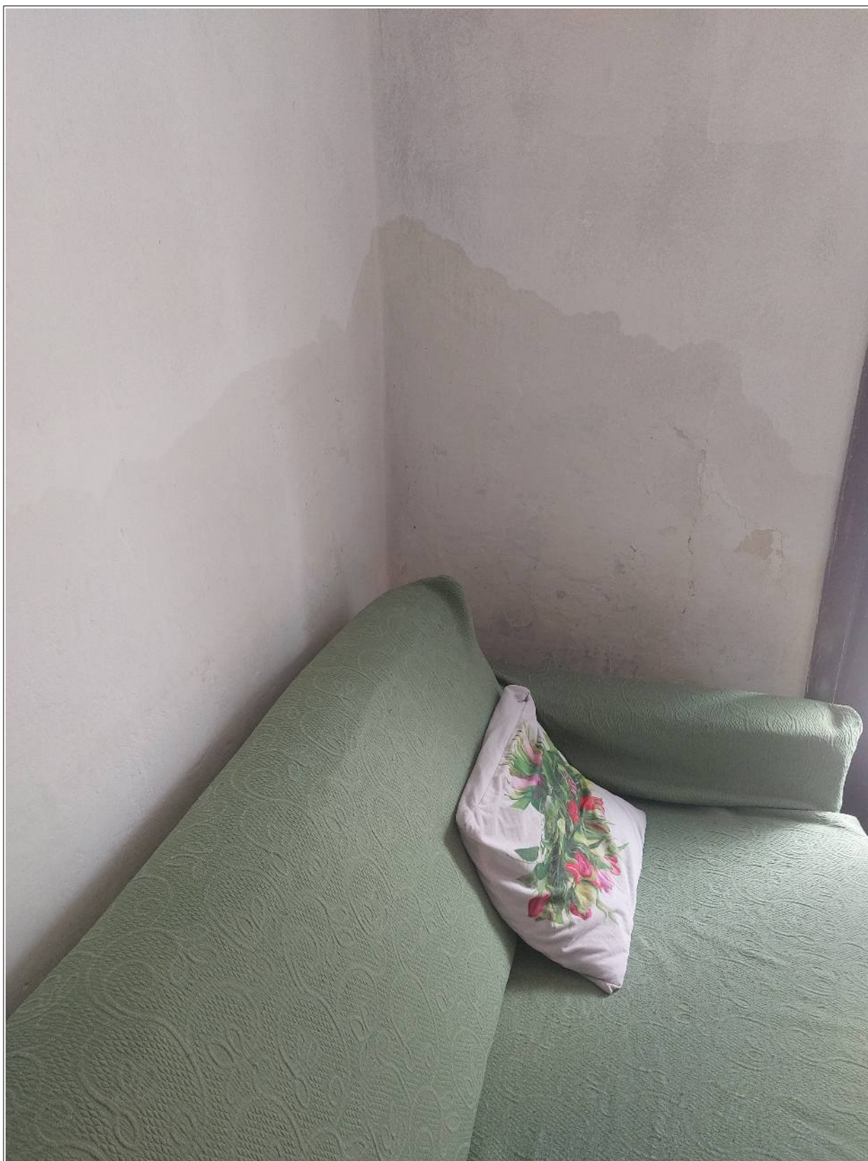
Foto n° 7 – 25/06/2024 - Comune di Azzano Decimo, foglio 38, part.36 – Macchia di umidità sulla parete del vano soggiorno.
