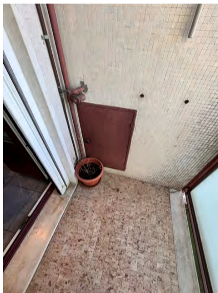
Immagini 10 e 11. Il balcone verso il retro del fabbricato con in evidenza la caldaia murale e lo sportello che contiene il contatore del gas.
