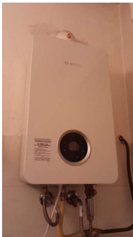
Dettagli – Scalda-acqua a metano per produzione acs
