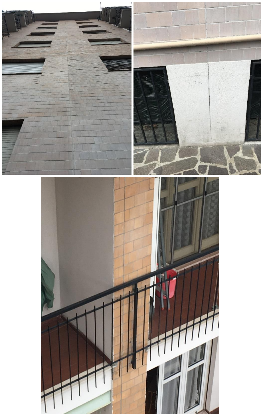
Figura 8 – particolare del giunto strutturale sulle facciate zona 4 (in alto) e zona 3(in basso)
