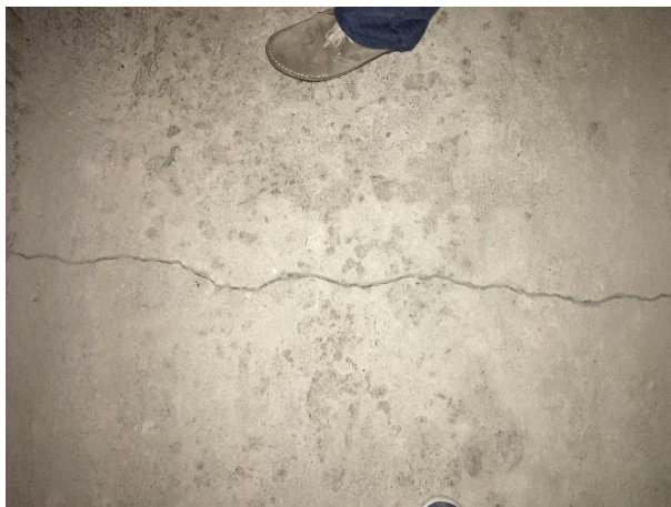
- Figura 28 – giunto su impalcato del sottotetto
