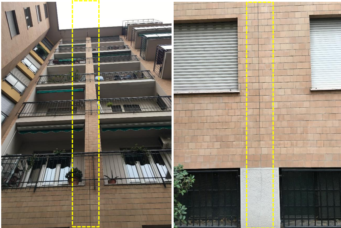
Figura 7 – particolare del giunto strutturale lato zona 3
