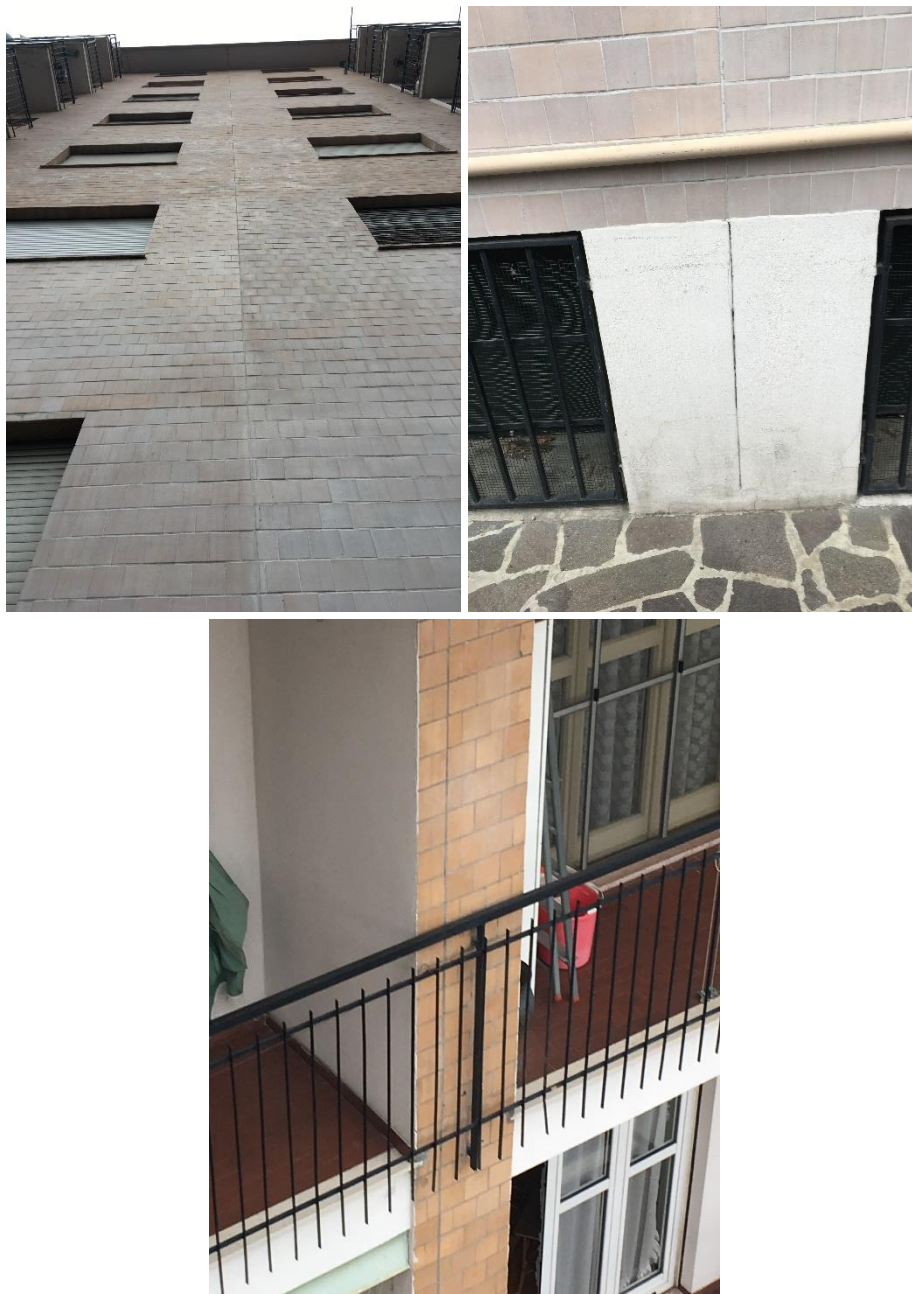
Figura 27 – particolare del giunto strutturale sulle facciate zona 4 (in alto) e zona 3(in basso)
