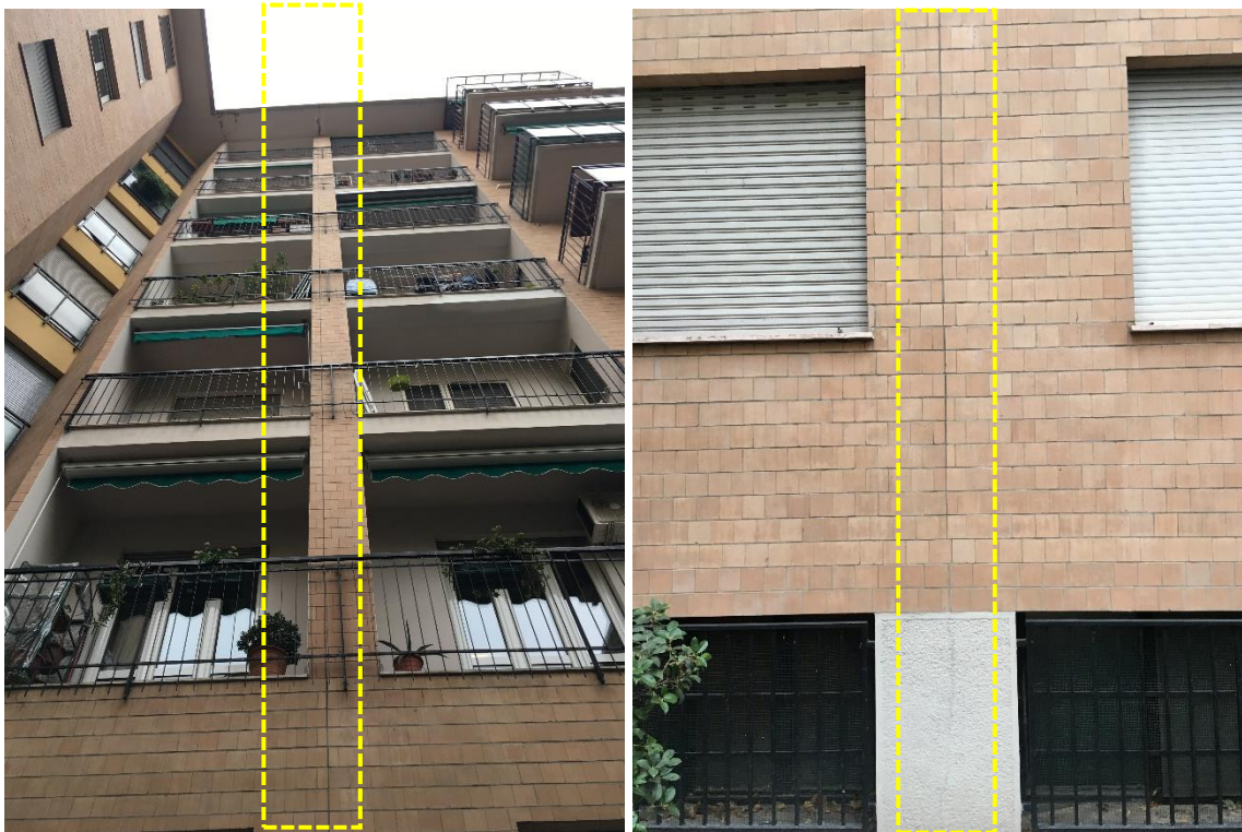
Figura 28 – particolare del giunto strutturale lato zona 3
